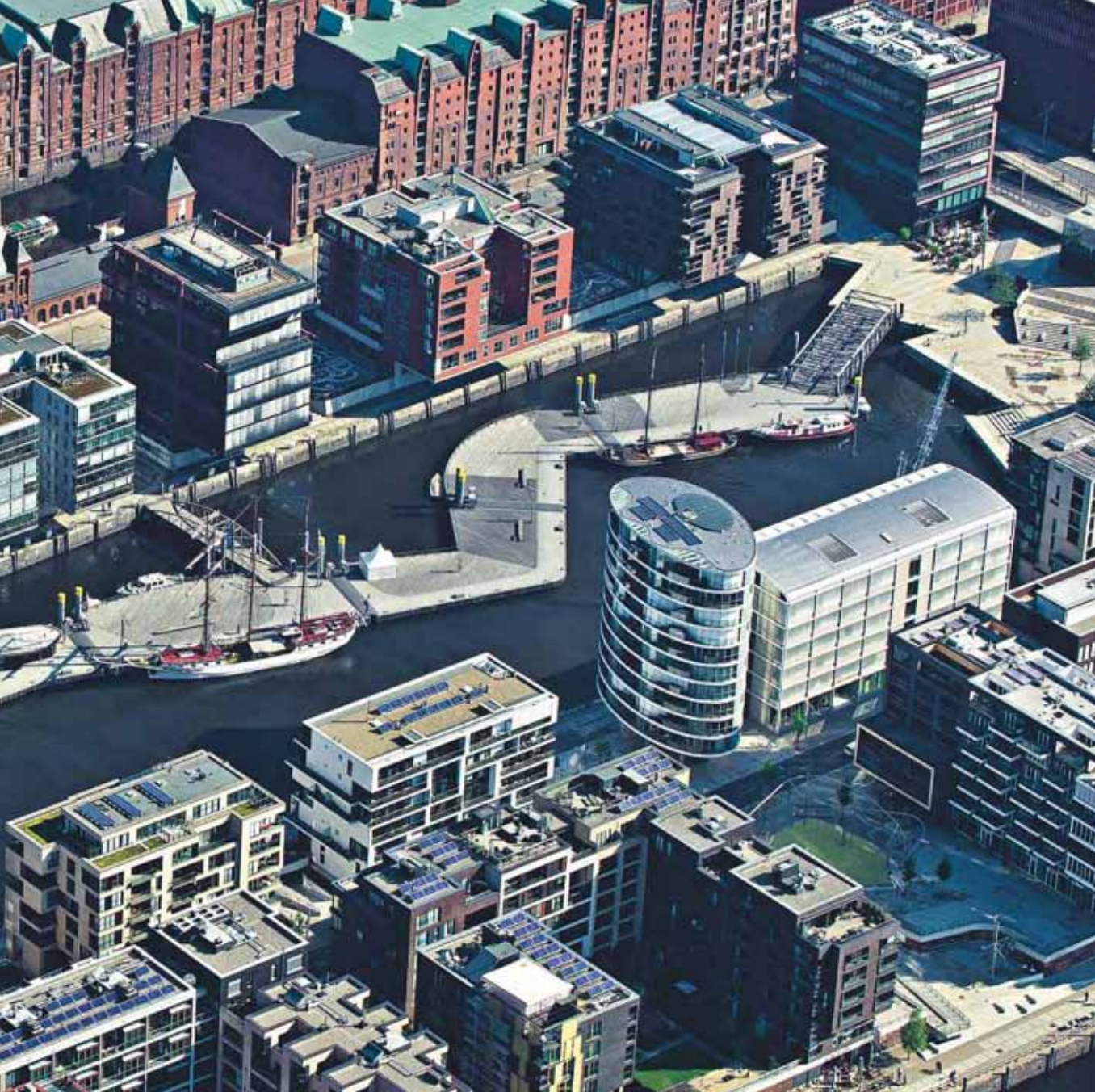
Begegnung von Alt und Neu: Die schwimmende Pontonanlage zwischen Speicherstadt und HafenCity bietet histori- schen Schiffen Liegeplätze.
