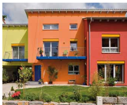
Fassaden zeigen Farbe (S. 6)
