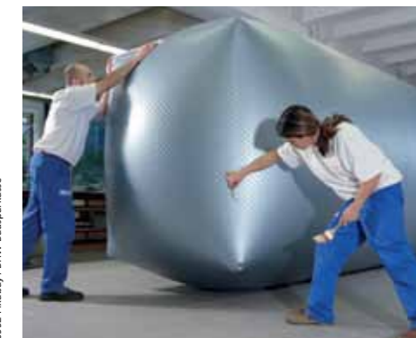
Schutz vor Rost durch neue Innenverkleidung
