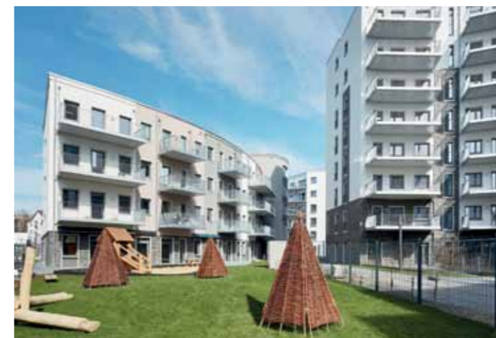
Neuer Wohnraum durch umgebaute Büros: Das „Living Circle“ in Düsseldorf
