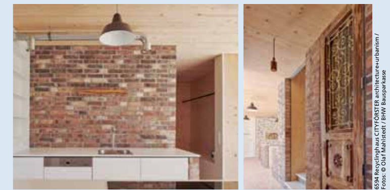
Baustoffe im Kreislauf: Innenwand aus Abbruchziegeln und historische Tür
