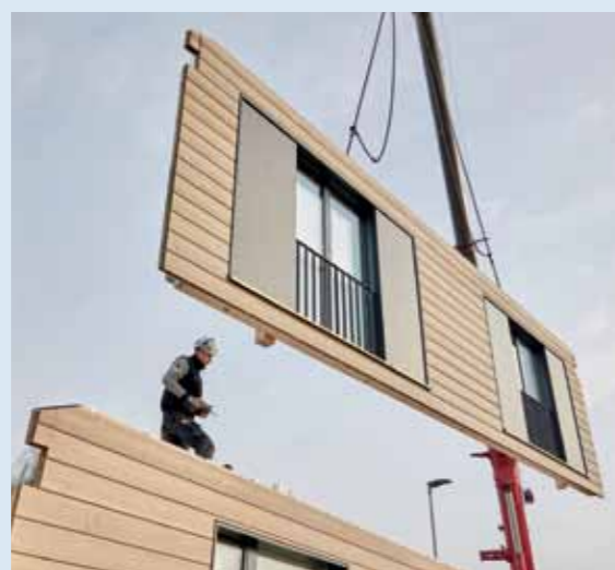
In der Fabrik vorgefertigt, vor Ort montiert
