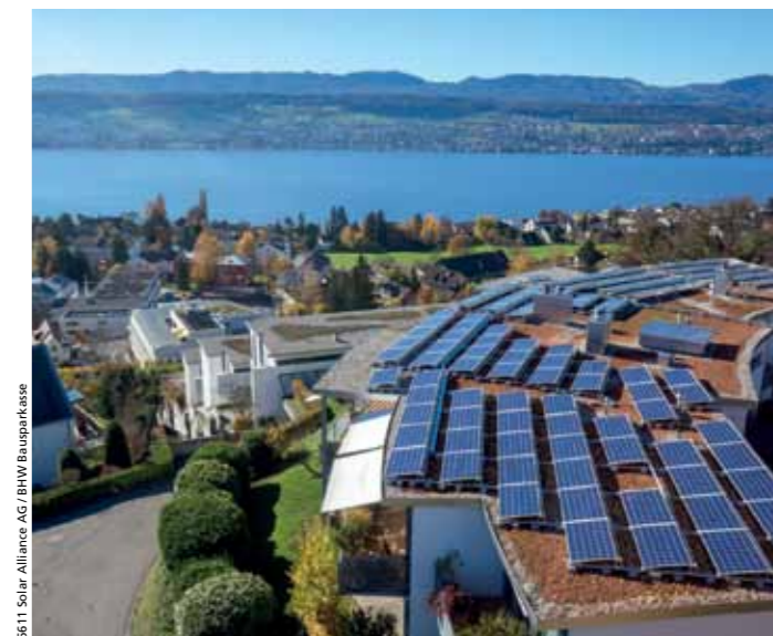
Reiche Energie-Ernte: Auf vielen Dächern ist noch Platz für eine Solaranlage
