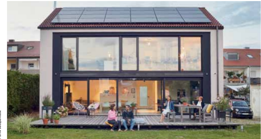
Nachher: Energetisch topfit, modern und komfortabel – Sanierungsergebnisse, die überraschen
