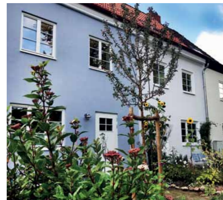
Unauffällige Fassade – aber außergewöhnlich gute Energiewerte!
