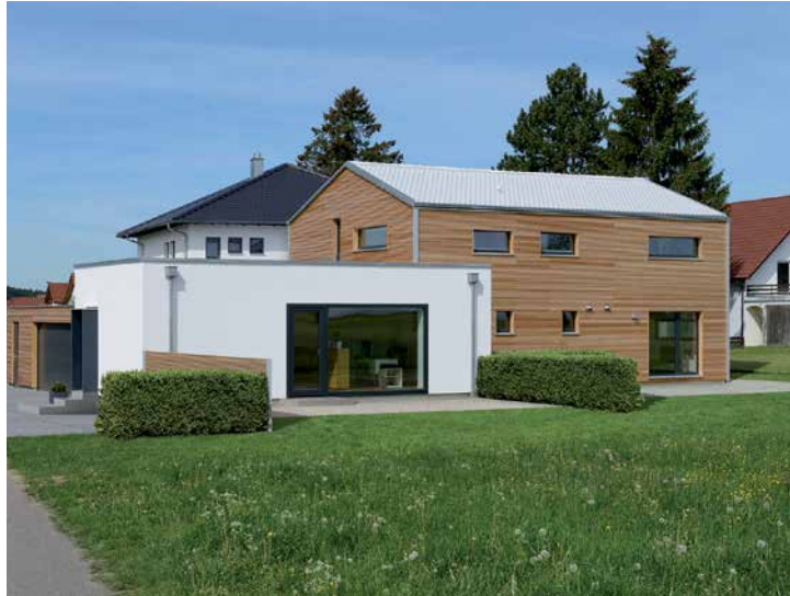
Anbauten schaffen Freiraum – barrierefrei und offen
