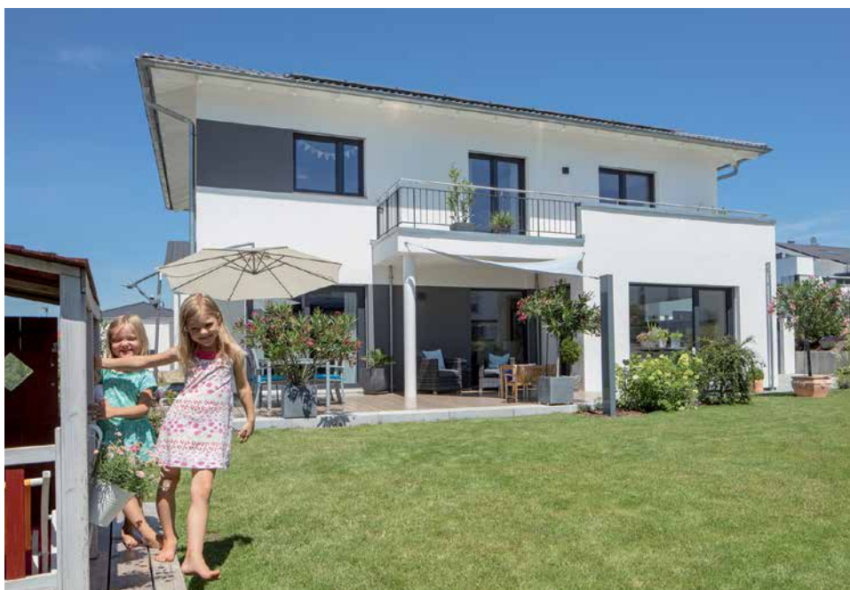
Zeit ist Geld: Fertighäuser sind dank hoher Vorfertigung in wenigen Tagen gebaut
