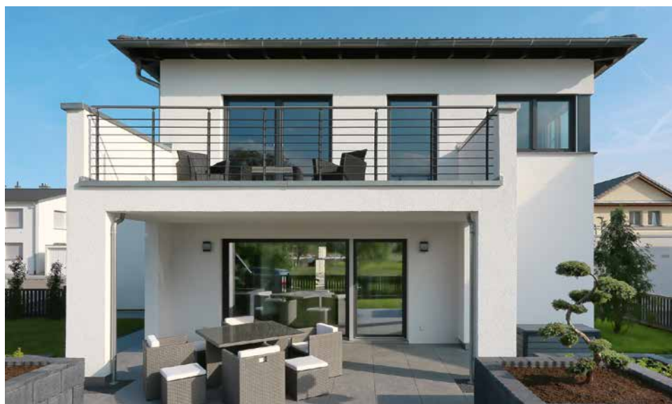
Hinter der verputzten Fassade dieses Fertighauses steckt zum Großteil Holz
