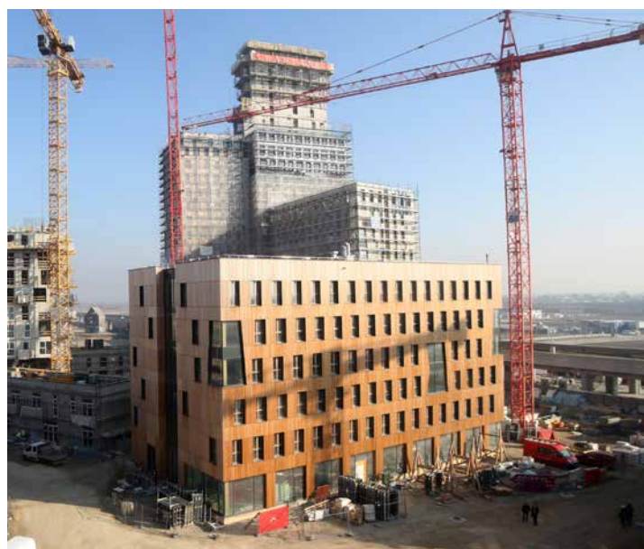
Ganz neu: Bauarbeiten am „HoHo Wien“, dem höchsten Holzhaus der Welt
